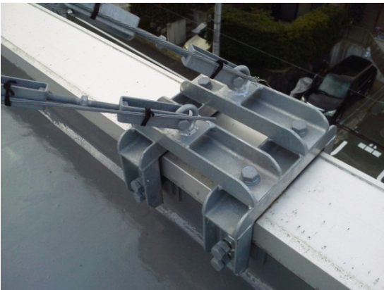
写真5 特注のステーアンカー金具
