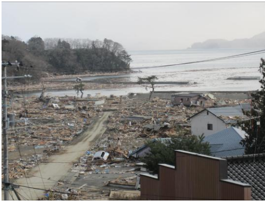
米崎中学校の海岸線の被災状況
