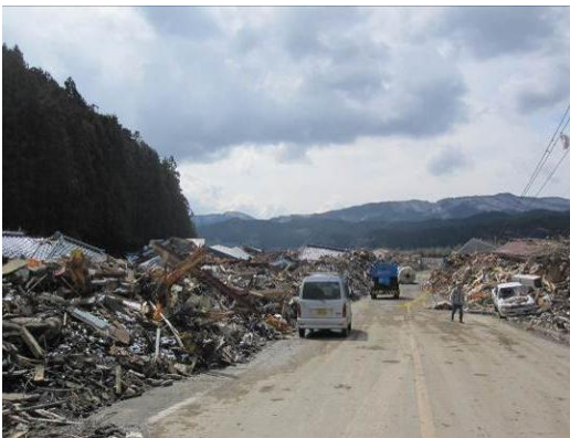
陸前高田市内の被災状況(3月17日)
