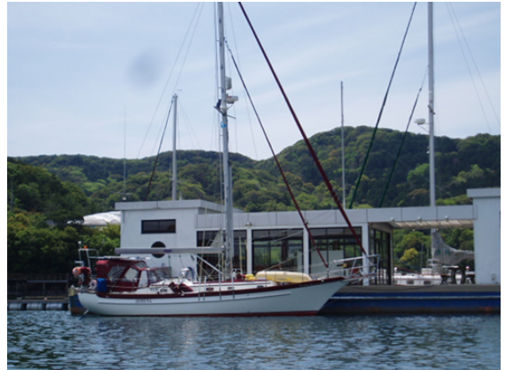
フローティングポートハウス
