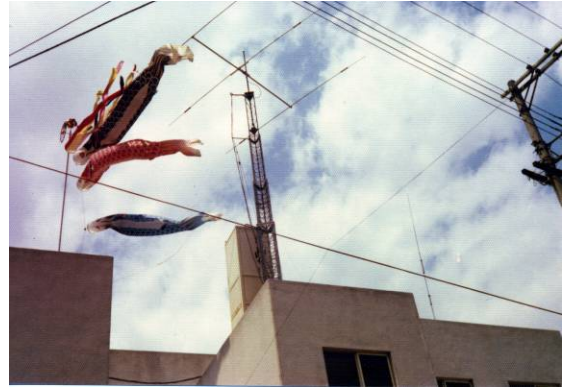
写真 2 新設の LM470D タワーと、それにのる CL33。脇に 12AVQ パーチカル ANT
