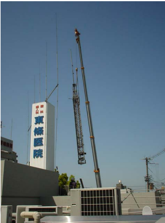
写真 6 タワーの入れ替え、ANT の載せ替え全てが一日で終了
