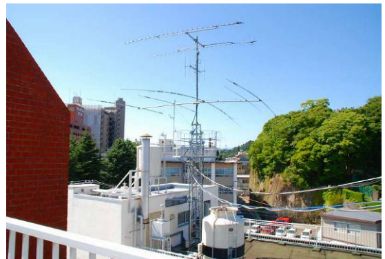
QFAの7Mロータリーダイポールアンテナ クランク、降ろしています
